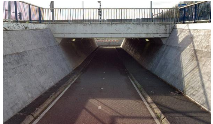
Figuur 15 Fietstunnel ten oosten ongelijkvloers kruispunt N203/N246.
